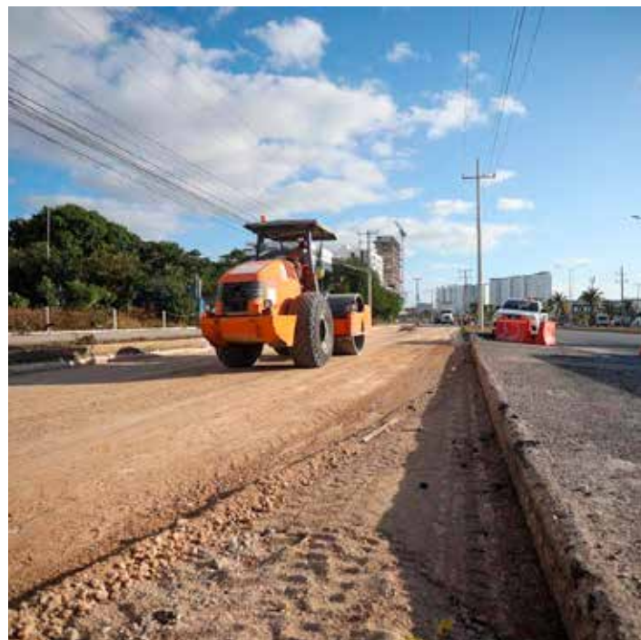
Las obras del bulevar Colosio llegan hasta la glorieta del Ceviche.
