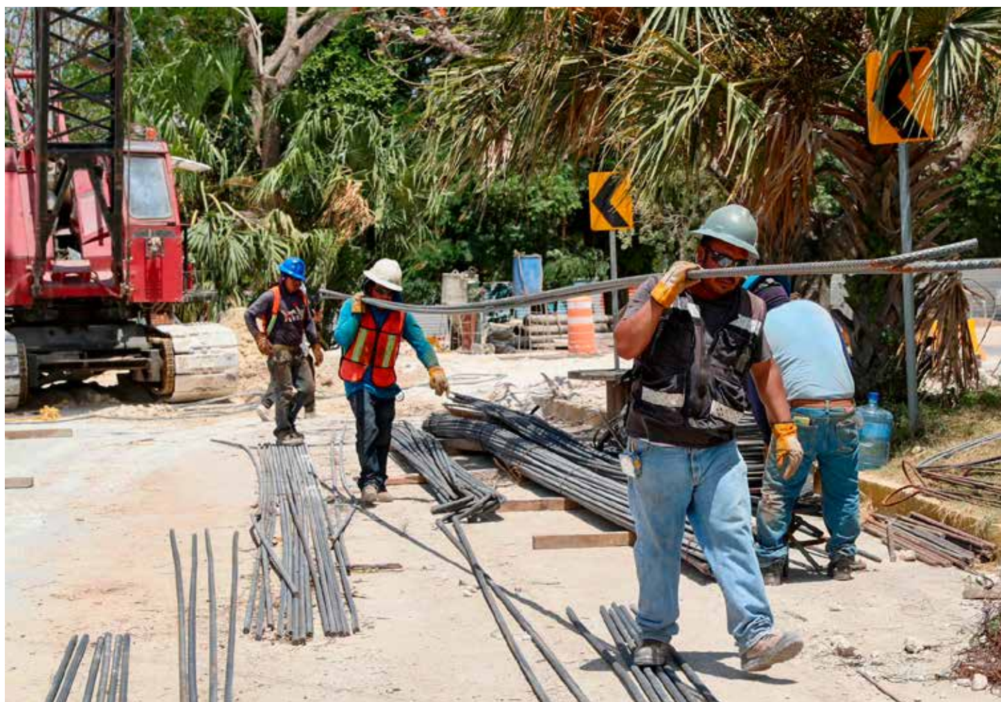
Trabajadores de la construcción piden mayor protección y seguridad.
