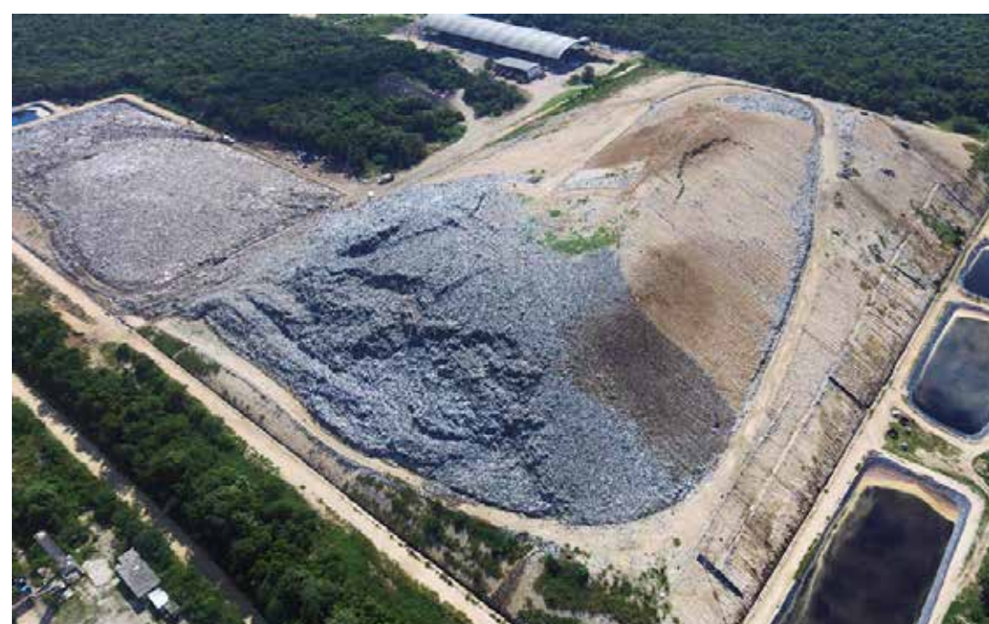
La próxima empresa concesionaria buscará el sitio para el nuevo relleno sanitario.
