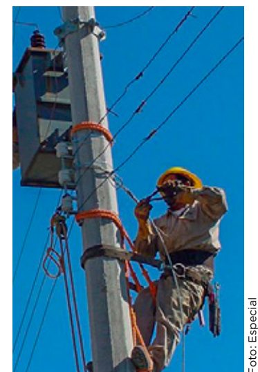
En Cancún, hay cambio en postes de luz dañados.
