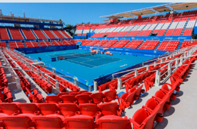
Los organizadores aceleraron el proceso de reconstrucción para el torneo que iniciará el 26 de febrero.
