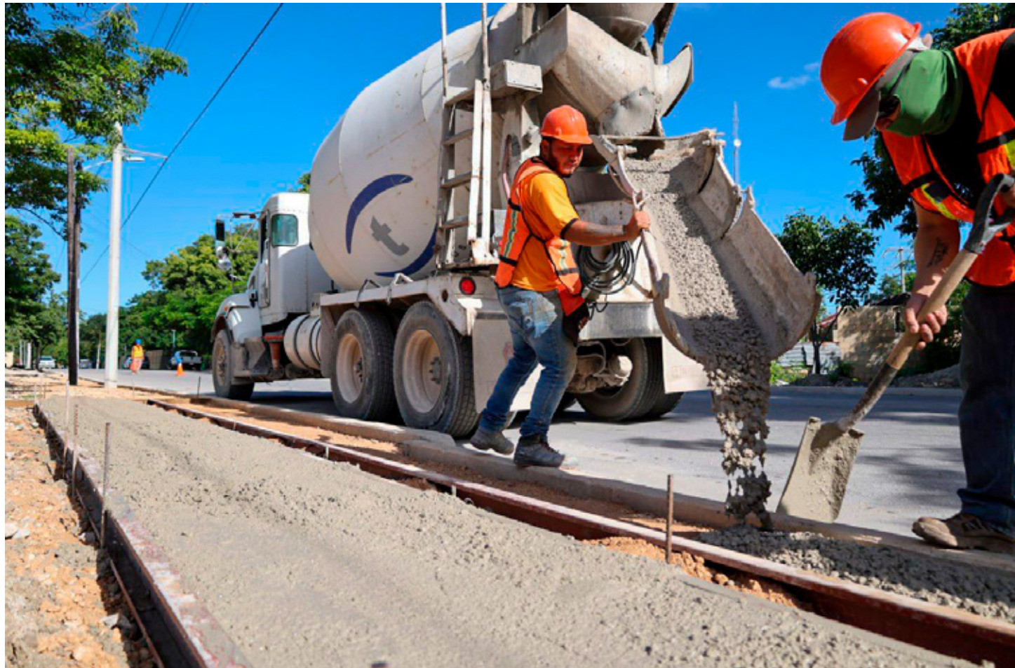
Las obras en la zona fundacional de Cancún llevan buen avance.
