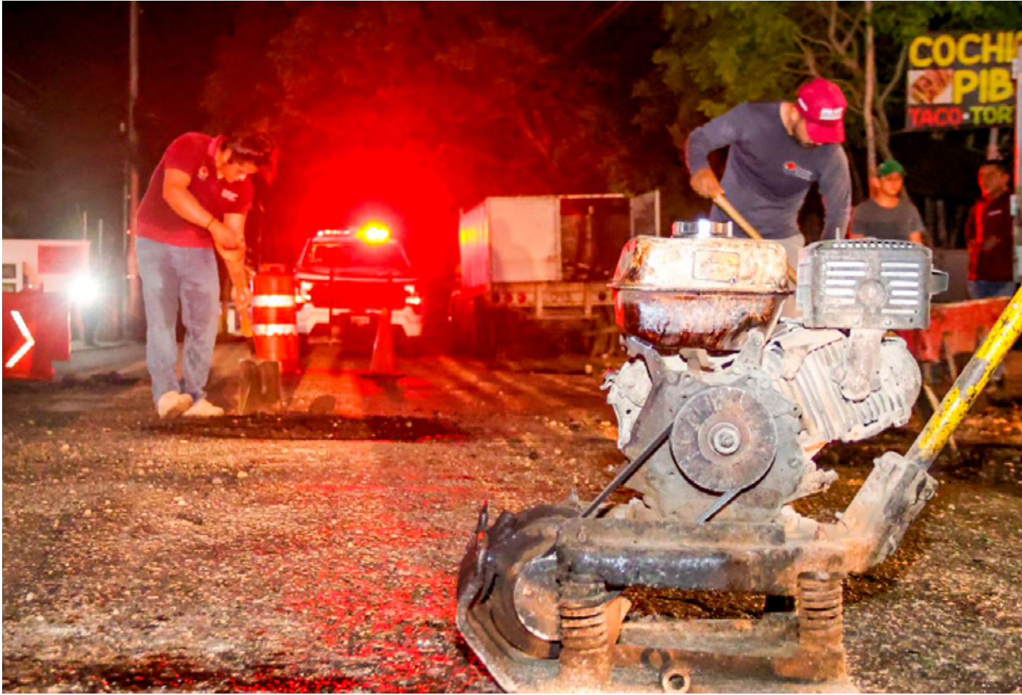
Las labores de bacheo actualmente están en diversos puntos de Cancún porque el clima lo permite.
