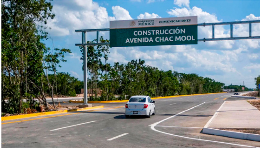
La Auditoría Superior de la Federación hizo observaciones a la SICT por irregularidades en la obra de Avenida Chac Mool.
