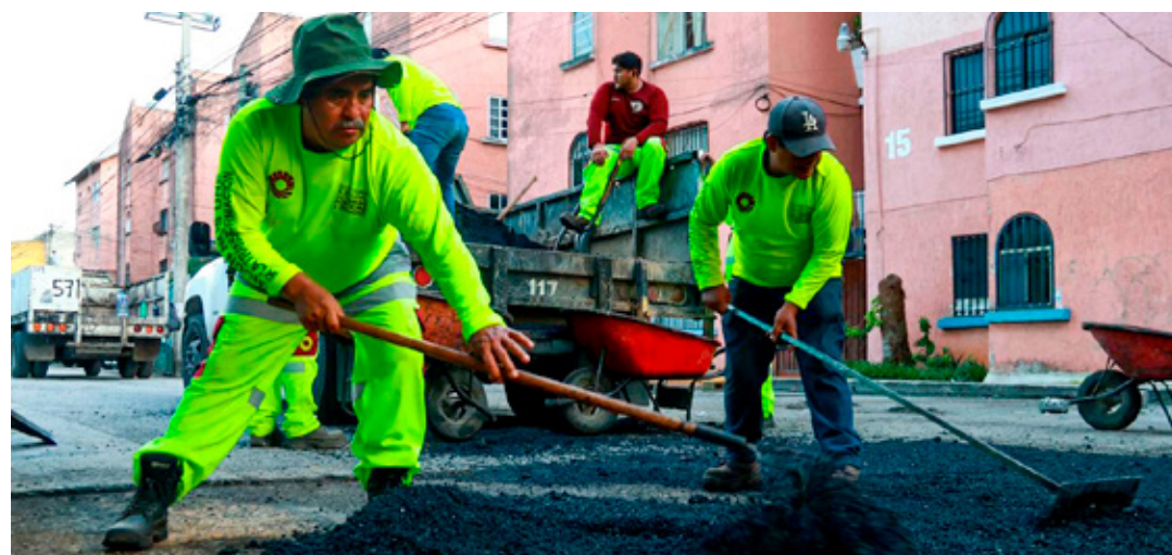
La Dirección de Pipas y Bacheo intensificó sus operativos de mantenimiento vial en Cancún, atacando los puntos críticos.
