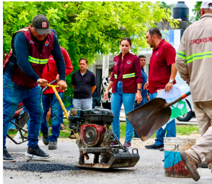
La Dirección de Bacheo y Pipas reportó un avance significativo en la rehabilitación de vialidades.
